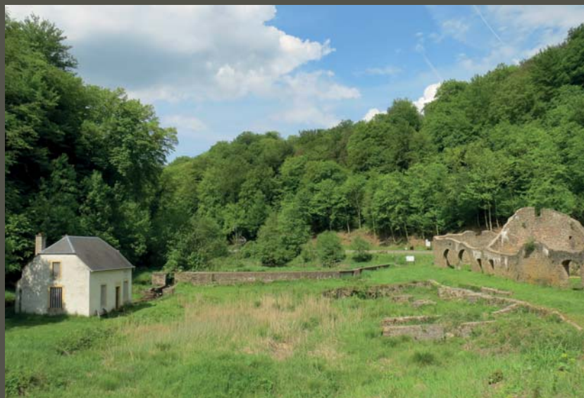
'Bureau des Forges' en 'Halle au charbon'
