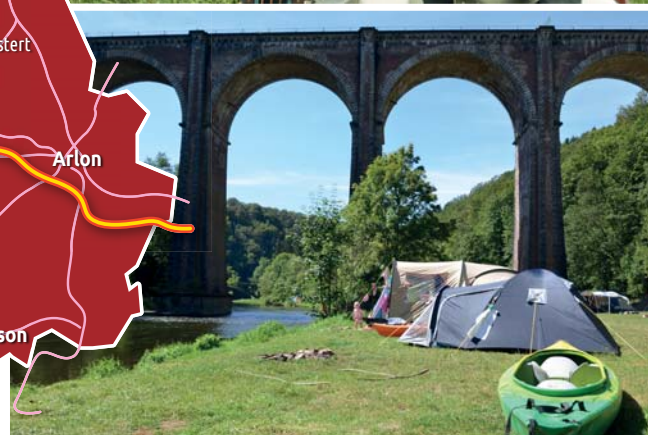
Ancien viaduc sur la Semois à Herbeumont (La Trêve)
