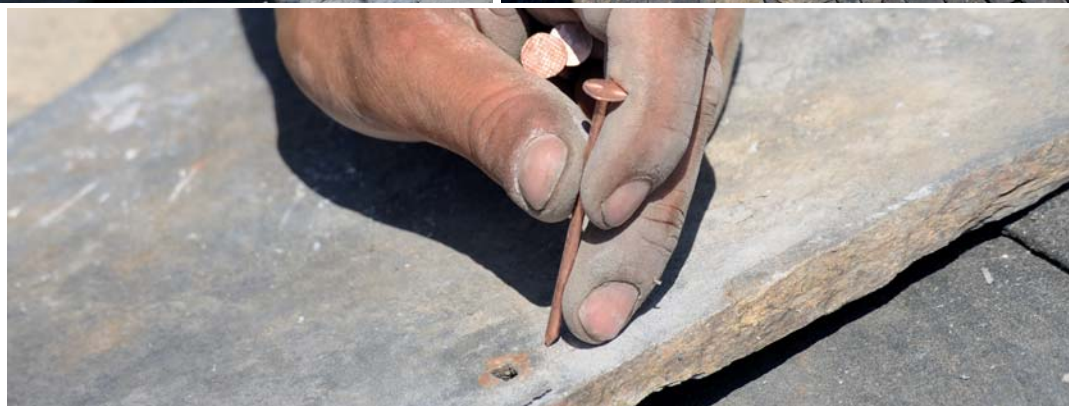
Les cherbains : plaques de schiste épaisses posées sur une chape d'argile.
