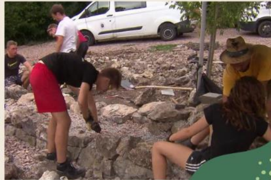
Philippeville – rénovation des murs de pierres sèches
