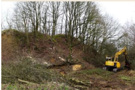
Villers-le-Bouillet – restauration d'une sablère
