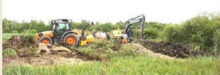
Habay – restauration d'une mardelle
